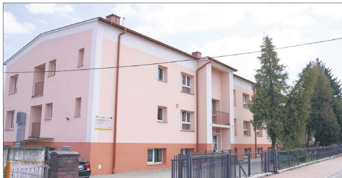
Internat po termomodernizacji
