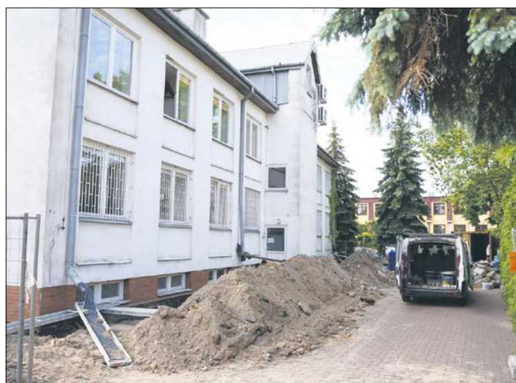
Budynek Starostwa w trakcie modernizacji
