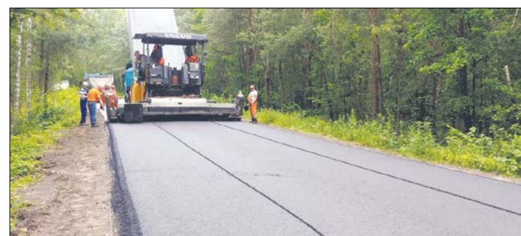
Prace remontowe przy drodze nr 1221L w Nowinach na odcinku 1462 mb.
