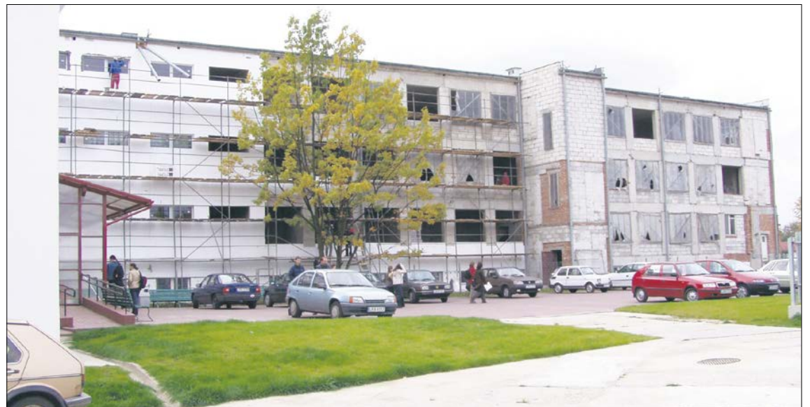
Budowa segmentu ZSP
