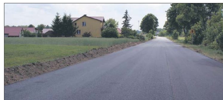
Droga powiatowa nr 1218L Borki - Ulan-Majorat po przebudowie w 2018 roku
