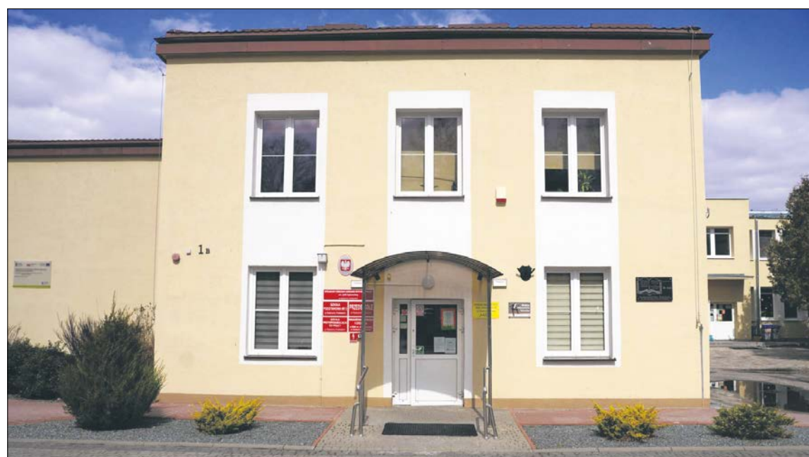
Budynek SOSW po termomodernizacji
